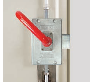
Panikriegel, ermöglicht das Öffnen der verschlossenen Tür von innen.
